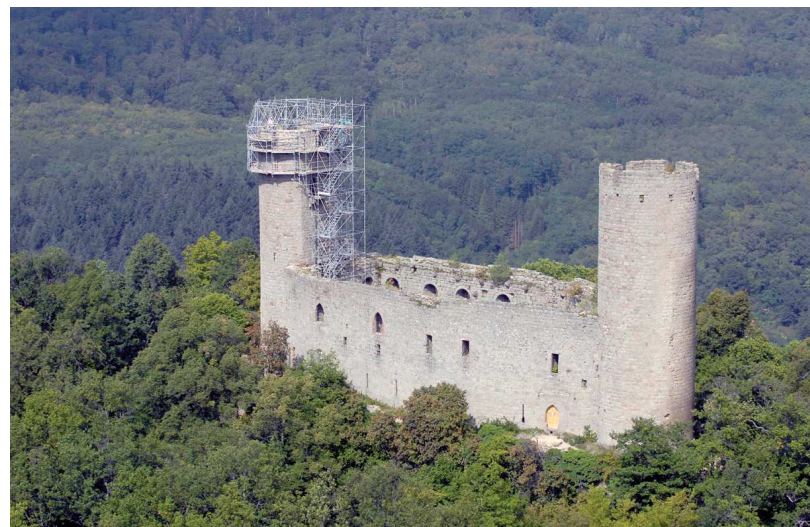
Vue aérienne des travaux du château d'Andlau, 2006.
