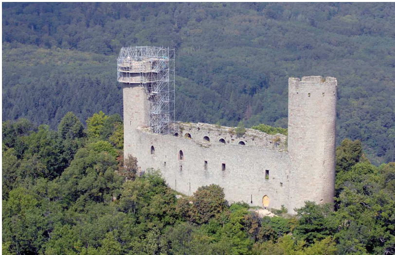
Vue aérienne des travaux du château d'Andlau, 2006.
